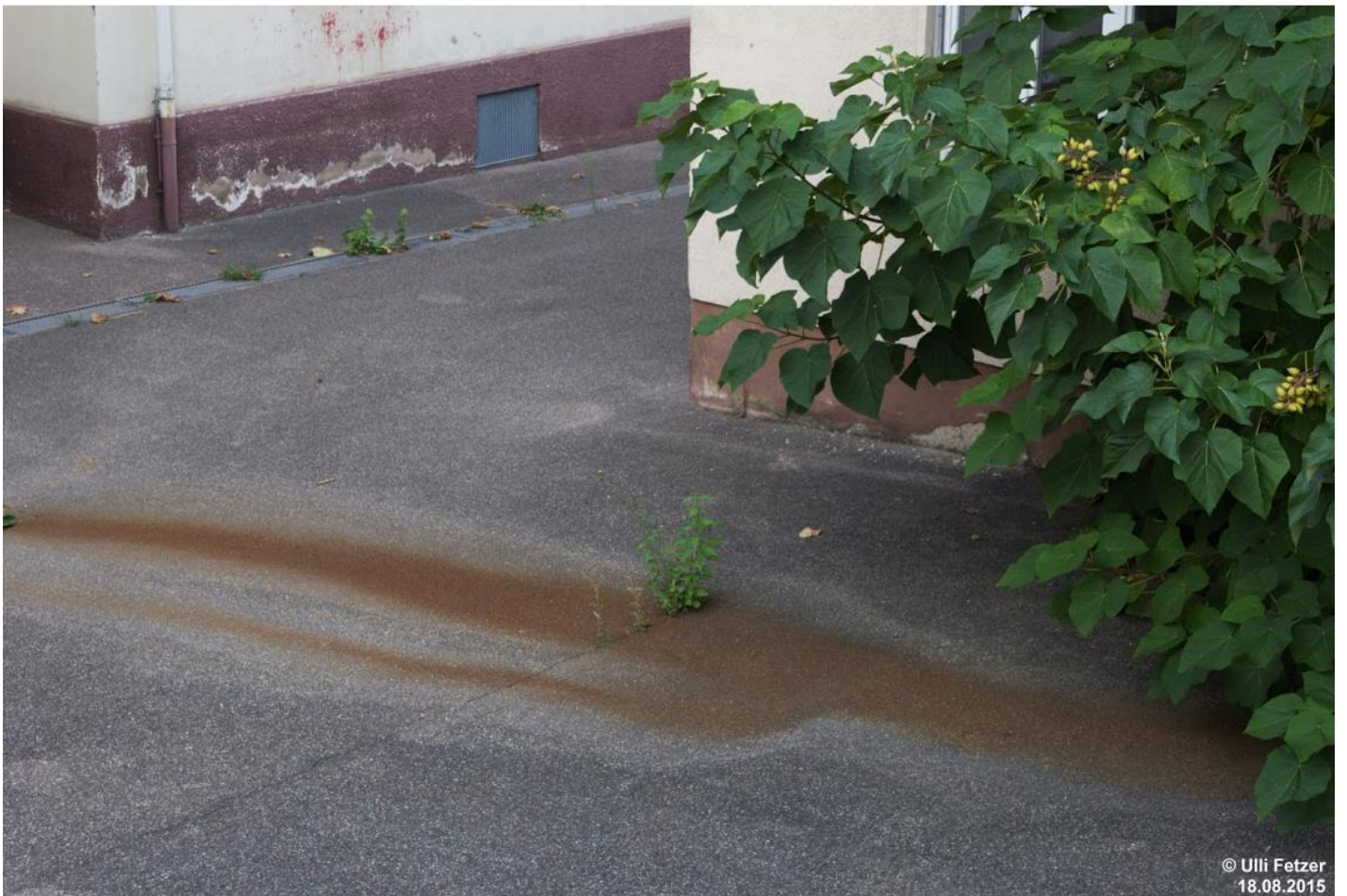
Breite Rostwasserspür nach Entleer-/Spülvorgang der GWM-Leitung im Polizeihof Willy-Brand-Str.
