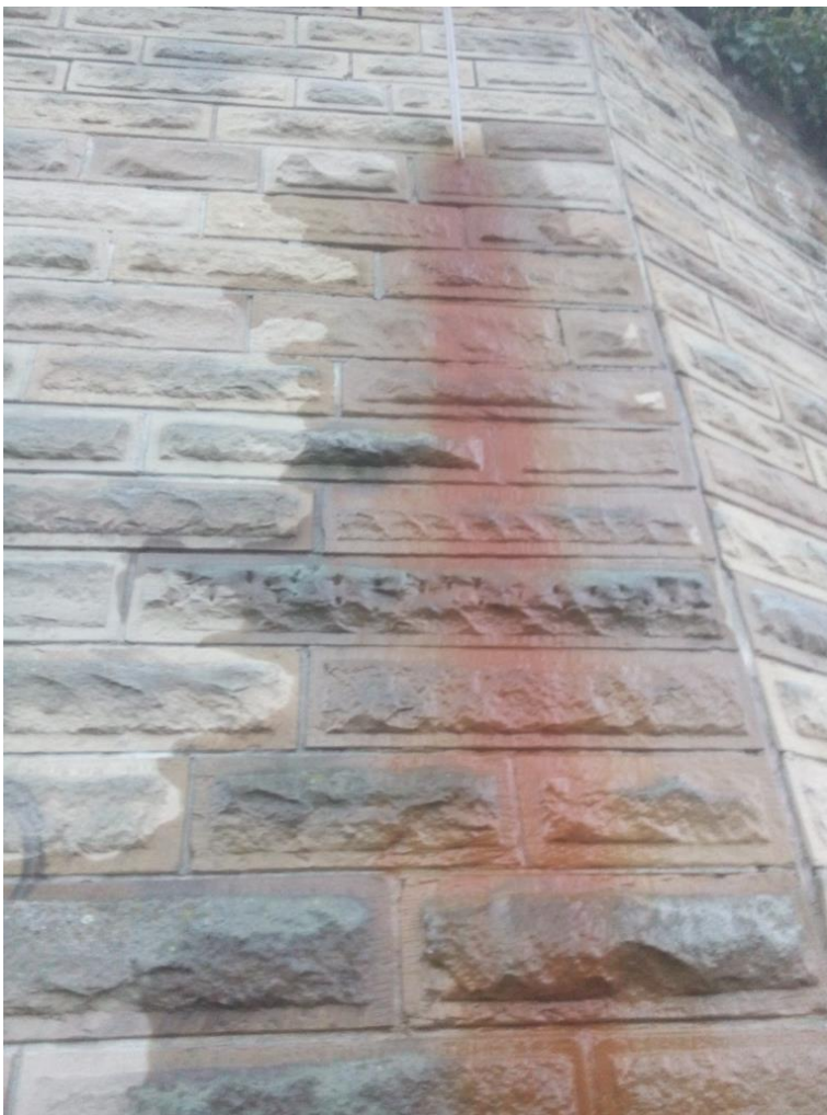
Breite Rostwasserspür nach Entleer-/Spülvorgang der GWM-Leitung im Polizeihof Willy-Brand-Str.
